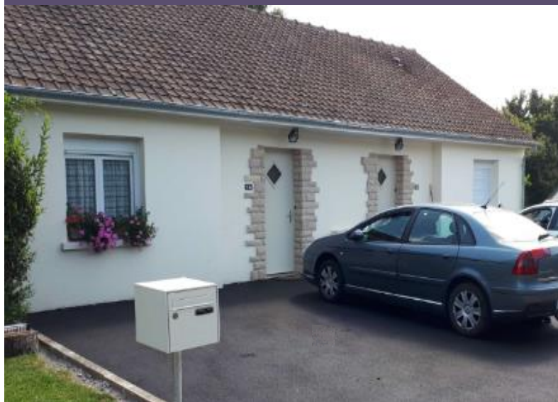
Opération de Réhabilitation
